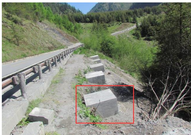
Stabilizační piloty (celé pod úrovní terénu)
